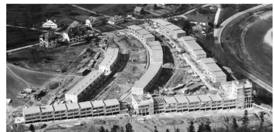
Ansicht von Süden während Erbauung 1930/31, BAZ
