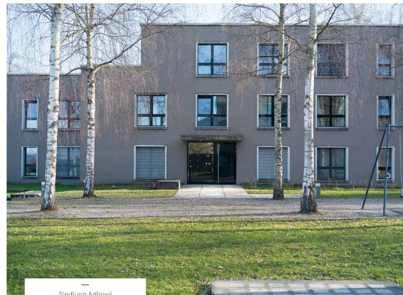
Siedlung Adliswil Glärnischstrasse
