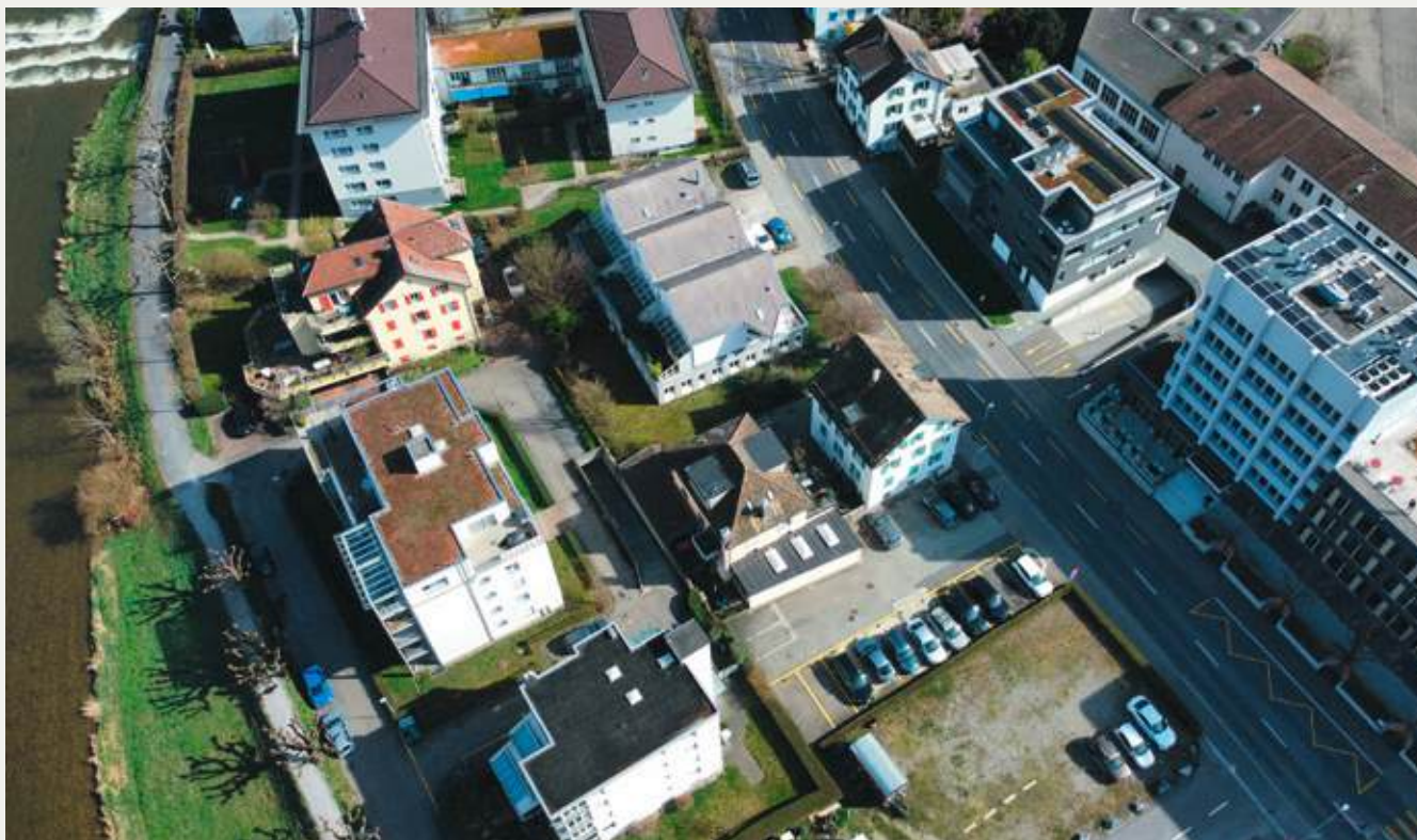
Luftaufnahme Adliswil mit Sihl links im Bild
