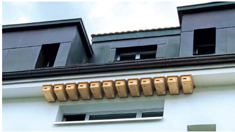
Noch nicht besetzt: Nistkästen für die Mauersegler an der Stüssistrasse 70
