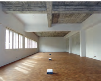
Der Umbau geht voran – Stand am 4. März 2016
