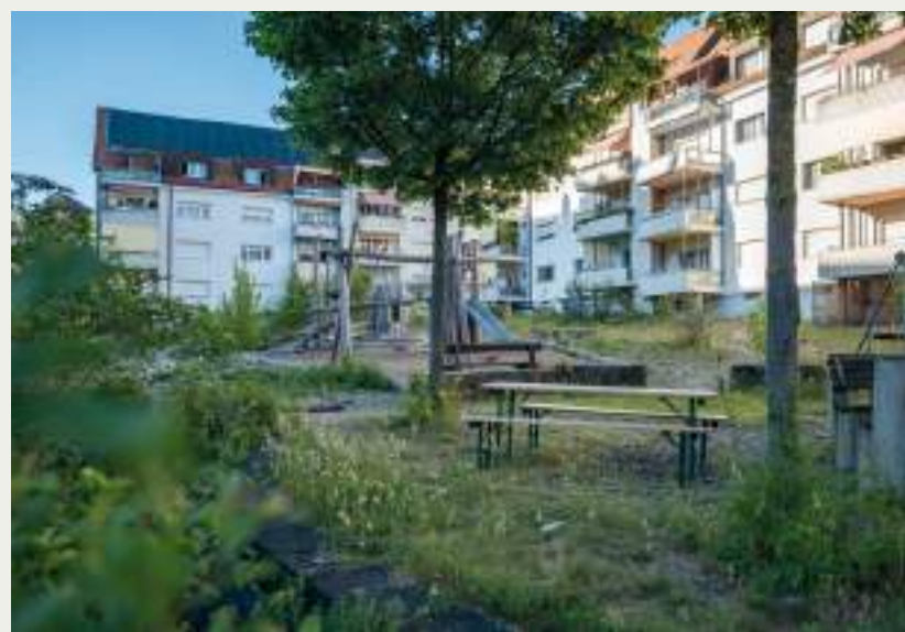
Siedlung Ilanzhof Gebäudeversicherungswert CHF 112'476'309, Stand 31.3.2023
