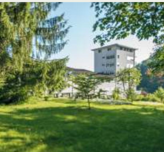
Siedlung Sonnenhalde I Gebäudeversicherungswert CHF 46'360'333, Stand 31.3.2023
