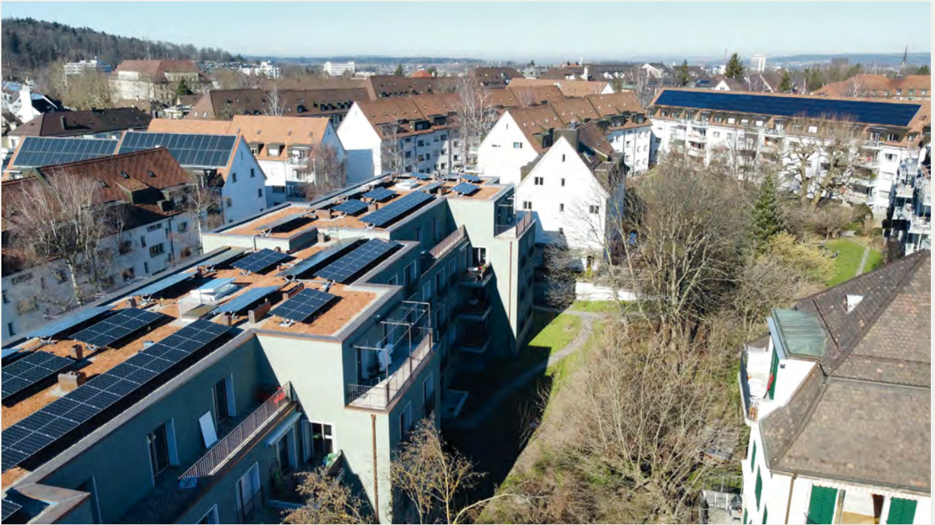
Ein Blick auf die Dächer des Ilanzhofs mit Photovoltaik-Anlagen.
