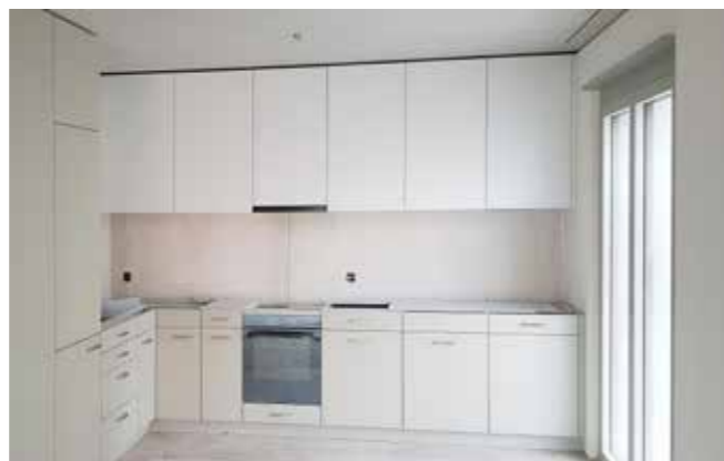
Badezimmer und Küche (im Bau)
